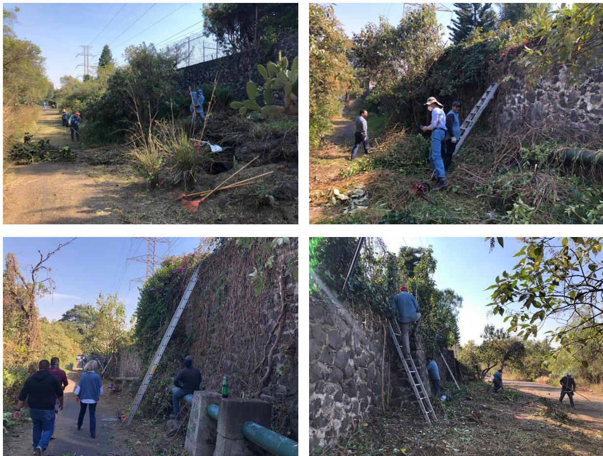
Fig. 26. Trabajos realizados por el personal de la Coordinación de Áreas verdes y forestación en la ZNP límite con Llanura.
