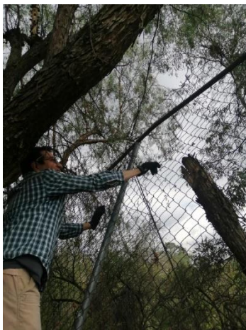
Fig. 18. Acciones de monitoreo. Verificación del estado de las rejas perimetrales de la Reserva.
