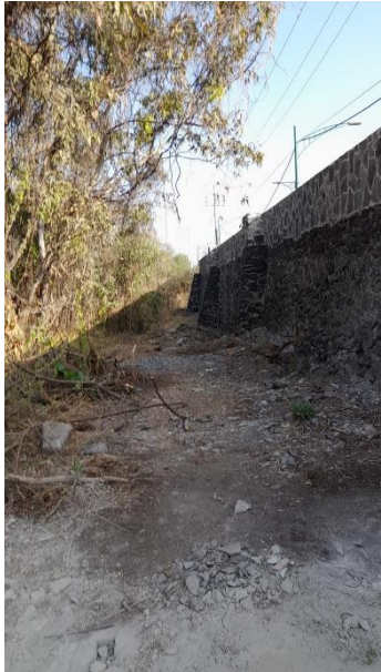
Fig. 33. Vista interior de los trabajos en barda de la ZNP con la Av. Insurgentes.
