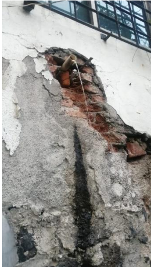
Fig. 31. Drenaje de un predio de la Calle Fuego que desemboca en la Reserva.
