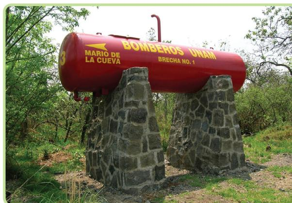
Figura 4. Tanques de agua para abastecer a los camiones de bomberos en caso de un incendio.
