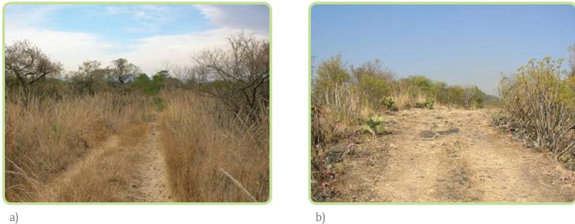
Figura 5. Apertura de brechas cortafuego, a) antes, b) después.
